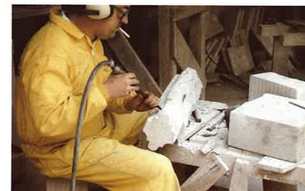
RESTAURACION DE VENTANAS
