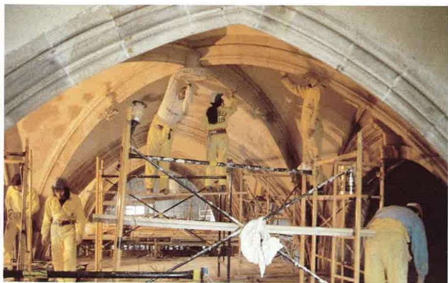
RESTAURACION DE BOVEDAS
